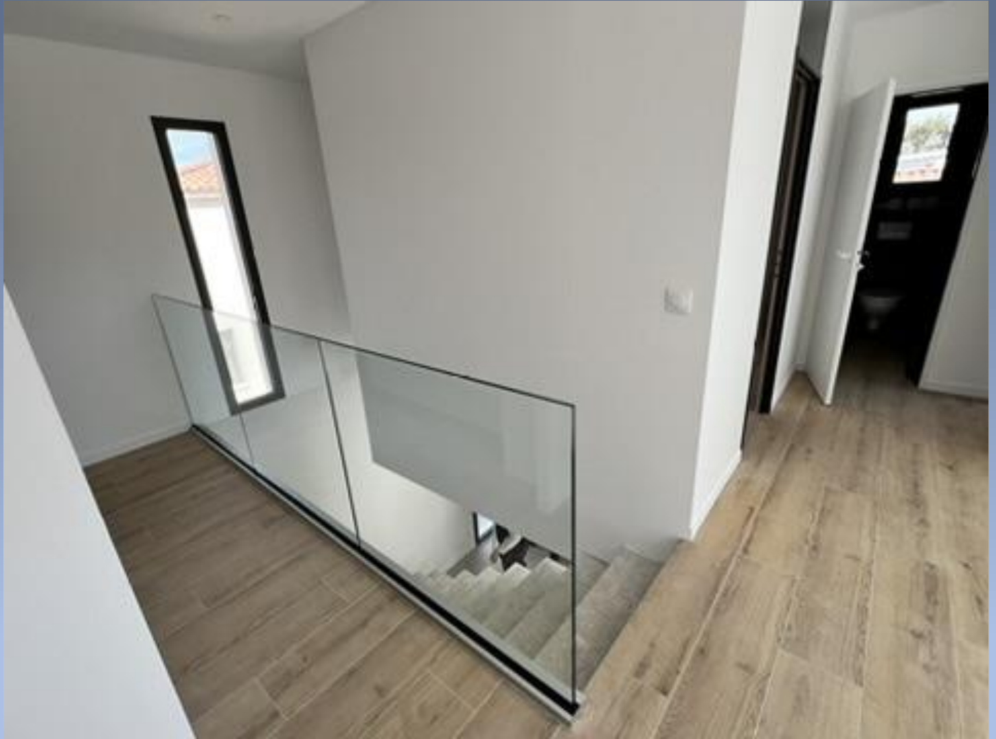
Modèle Verre sur Rail – Rail aluminium posé sous la chape Verre Feuilleté Trepmpé
