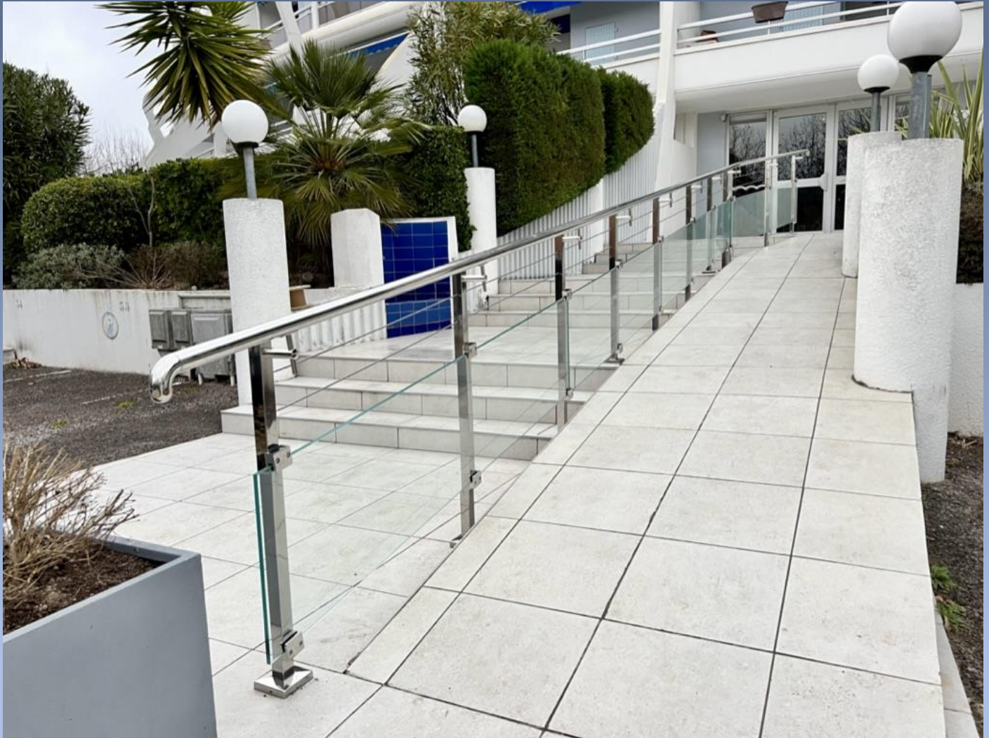
Main courante rampe accès – Inox poli miroir et verre feuilleté trempé
