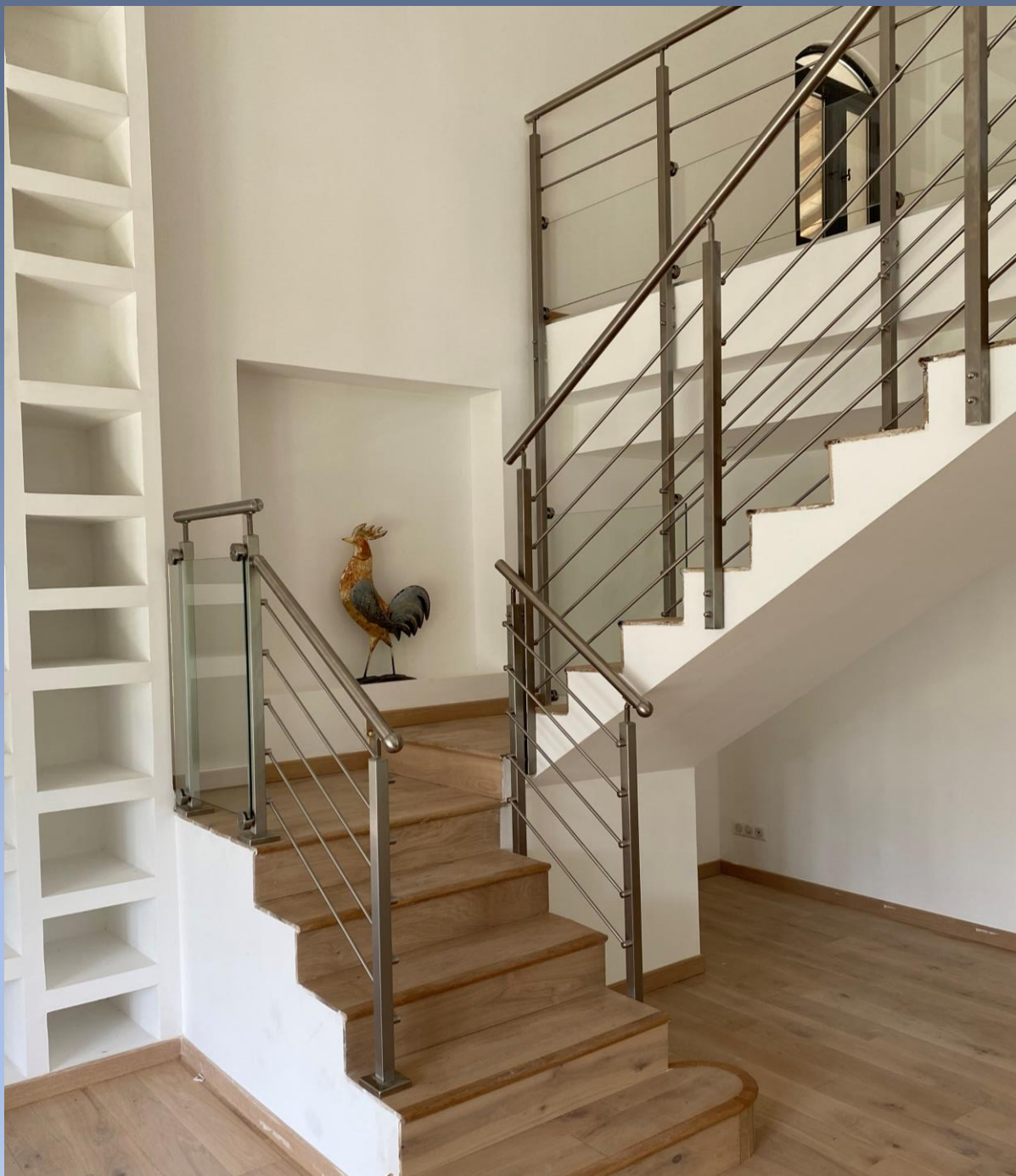
Escalier 5 Lisses – Palier Verre Sous Main Courante
