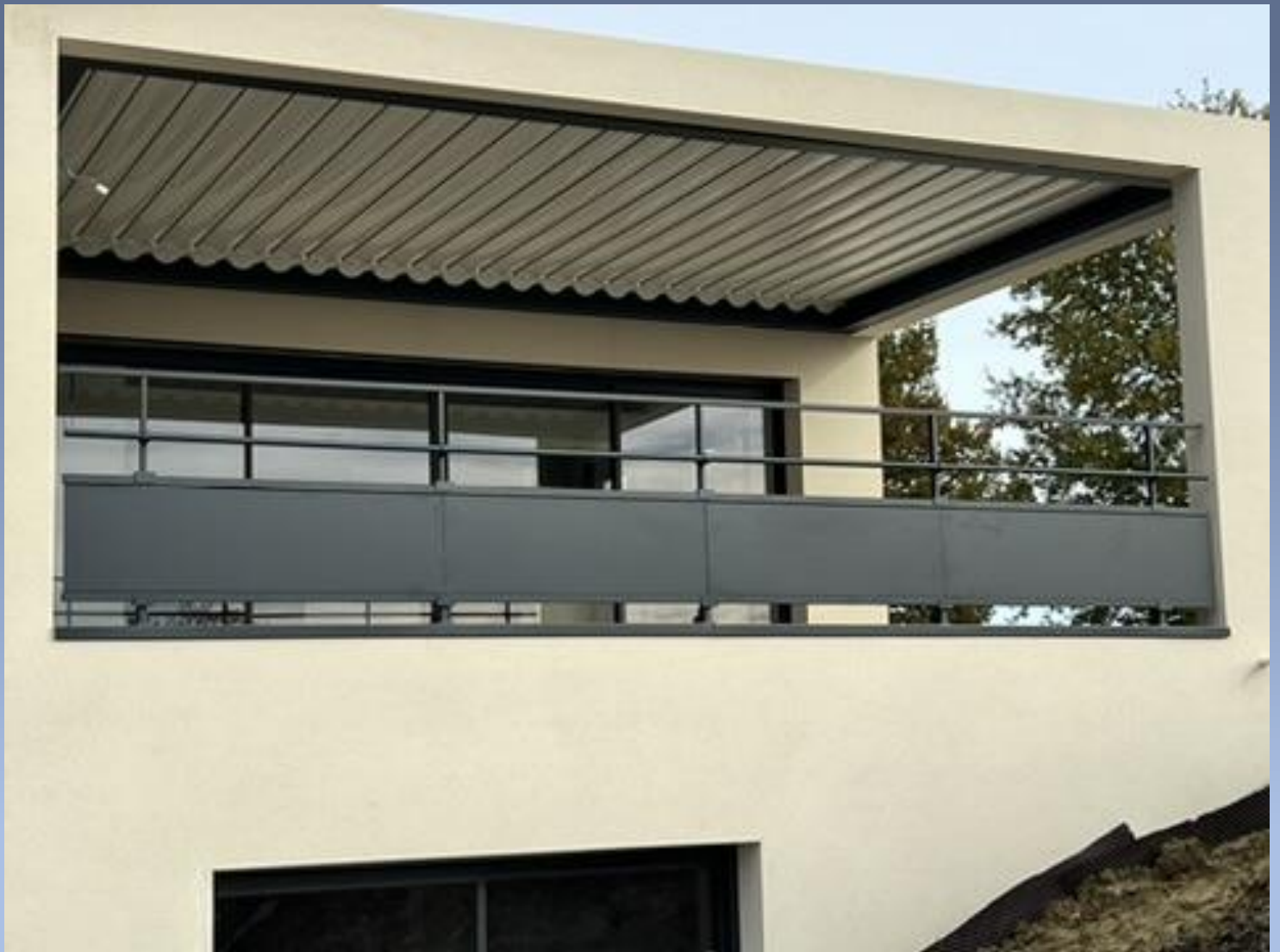
Modèle Aluminium partie basse tôle alu pleine, 1 lisses haute diamètre 30 mm
