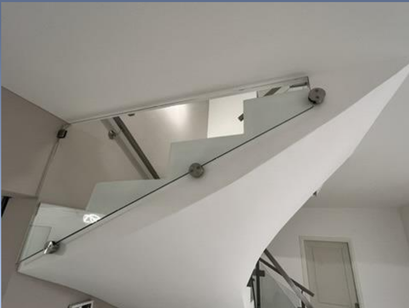
Sécurisation palier intermédiaire par verre feuilleté et pincés inox
