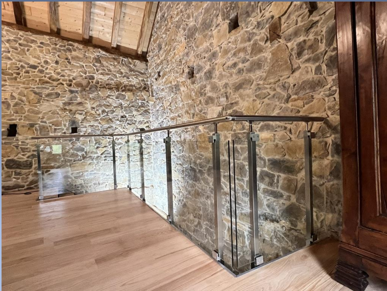
Modèle Inox verre sous main courante Pose en applique sur poutre bois
