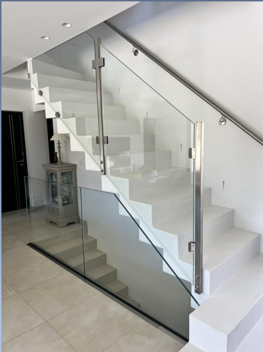
Escalier Garde corps Verre plein Inox et Verre feuilleté trempé RDC modèle verre sur Rail – Rail aluminium en applique et verre feuilleté trempé
