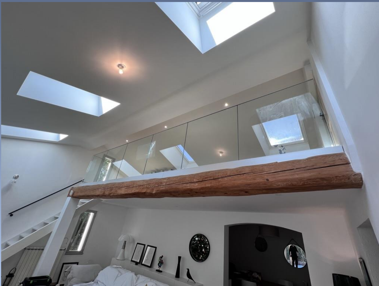
Modèle Verre sur rail aluminium – Ici pose sur poutre bois
