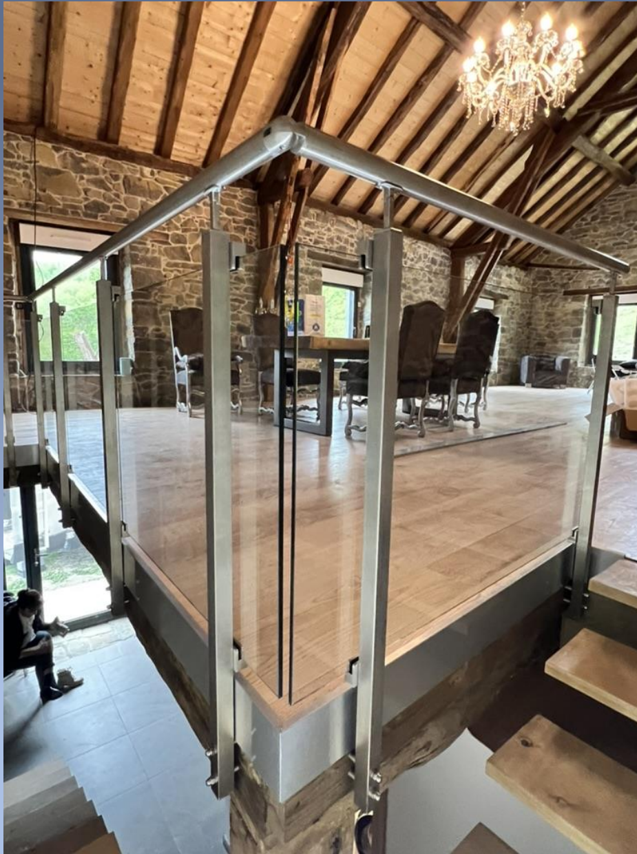
Modèle Inox verre sous main courante Pose en applique sur poutre bois
