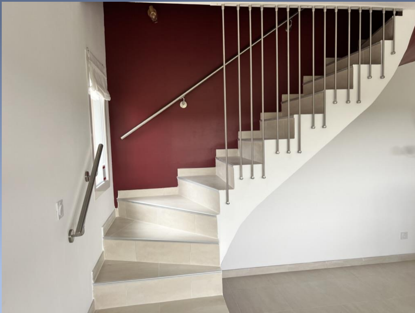
Harpe 3 – Espaces verticaux inférieurs à 11 cm, tiges inox pleines 14mm
